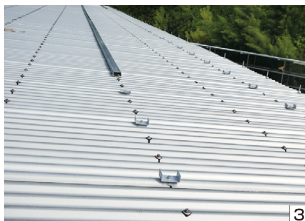
コ型金具にC型鋼を取り付けます。
