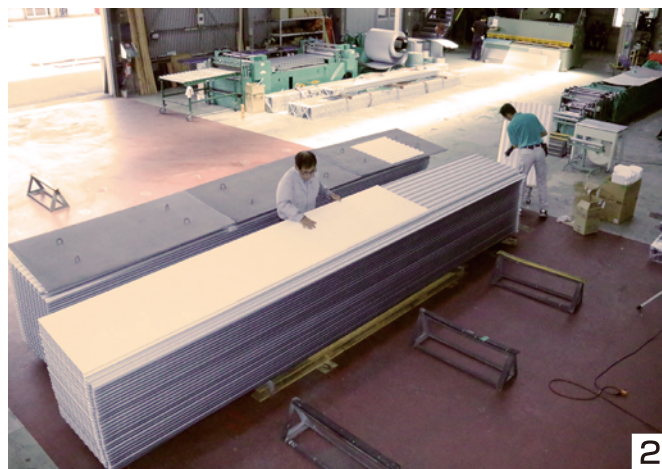
2 当社工場内のダンネツイーナミ張り作業
