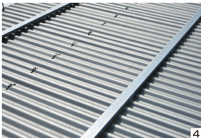
既設の大波ドリルスクリーブスを利用して コ型金具を取り付けます。
