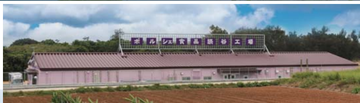
(株)みつわ産業 (沖縄県うるま市) 設計:(株)現代設計/施工:玉鐵建設(株)
