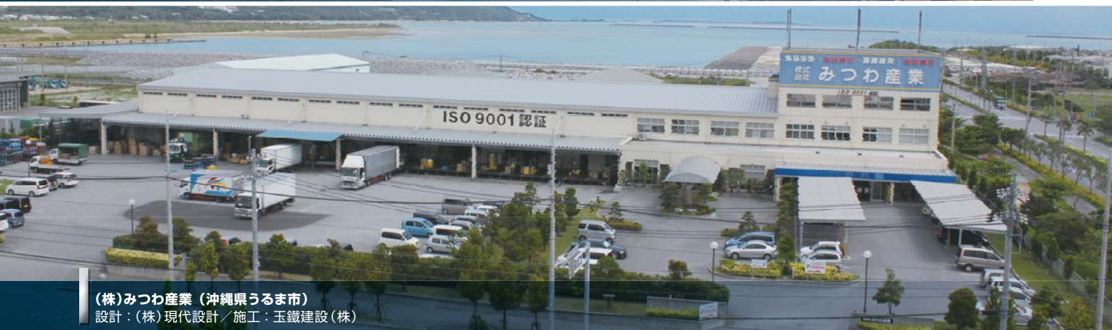
新日本石油精製(株) 水島精油所 潤滑油物流センター (岡山県倉敷市) 設計/施工:(株)大本組
